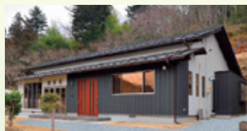
高齢化に備えて木造2階建を平屋に減築
