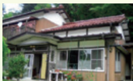
高齢化に備えて木造2階建を平屋に減築
